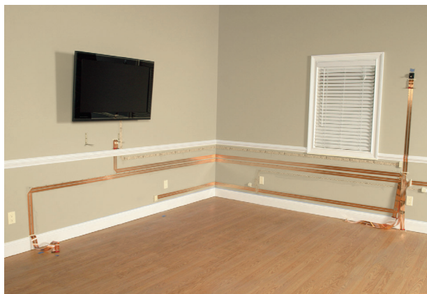
Ecco un esempio che utilizza cavi piatti per allestire un impianto Home Theater. I cavi scorrono lungo il muro e, terminata l'installazione, vengono rifiniti con dello stucco e dipinti dello stesso colore della parete, diventando invisibili
